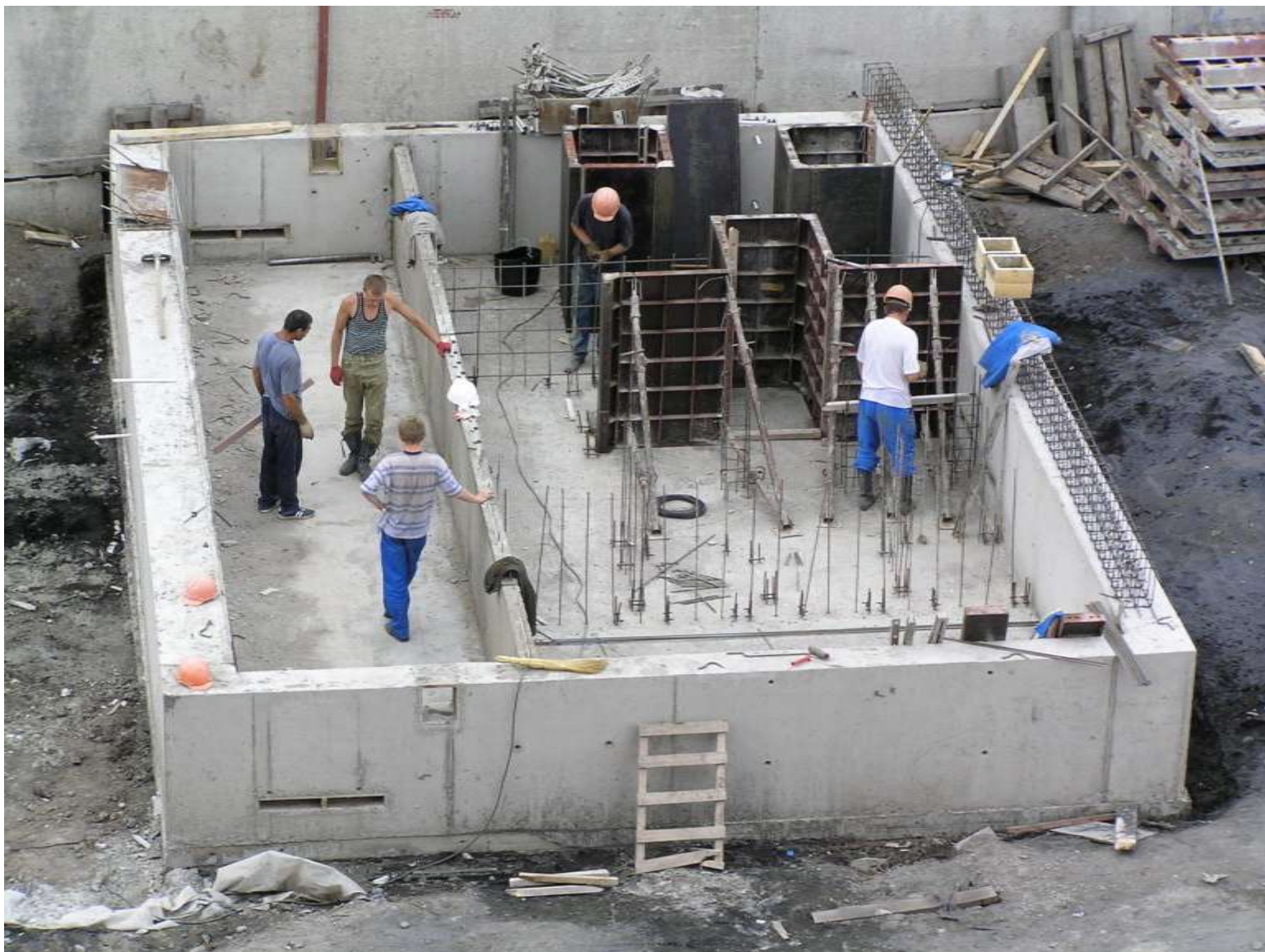
ФУНДАМЕНТНАЯ ПЛИТА ЗДАНИЯ ТРАНСФОРМАТОРНОЙ ПОДСТАНЦИИ
