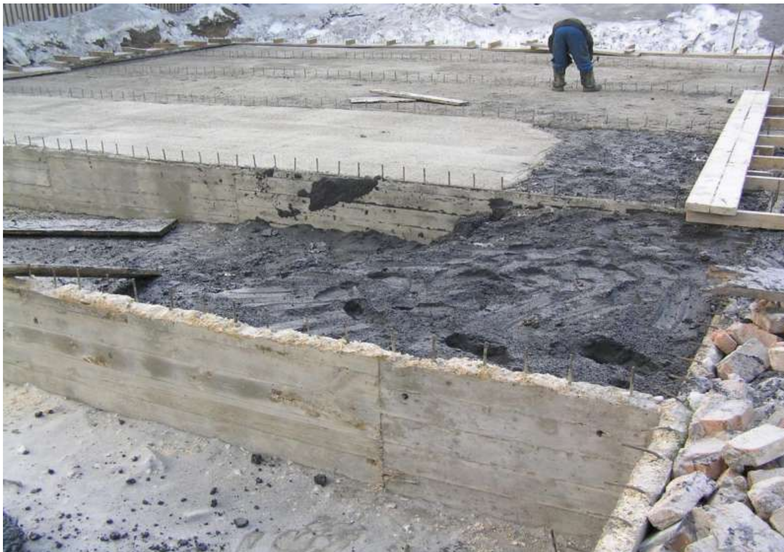
БЕТОНИРОВАНИЕ ВЕРХНЕЙ ФУНДАМЕНТНОЙ ПЛИТЫ ЗДАНИЯ АБК
