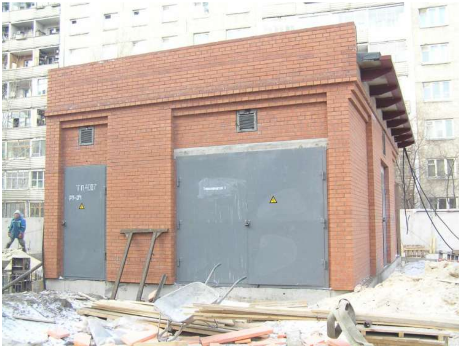
Трансформаторная электроподстанция на подтапливаемой территории
