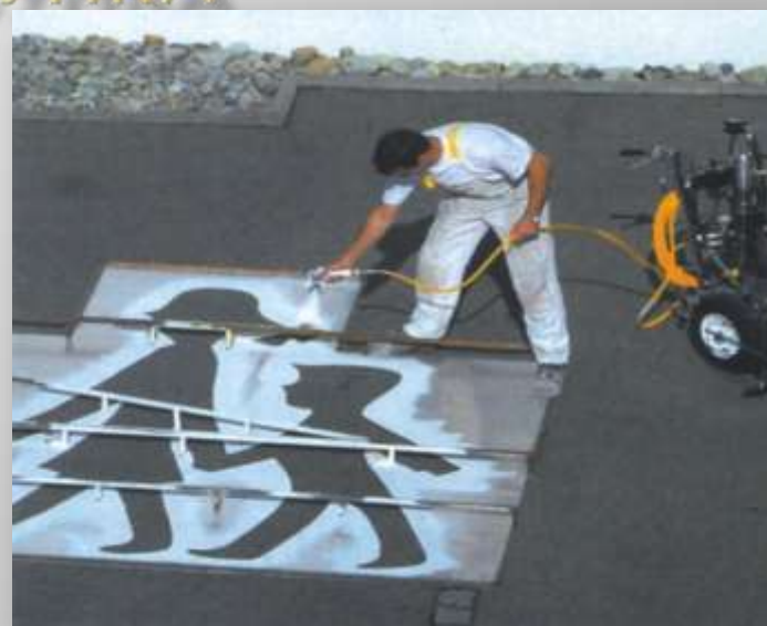
Ручной способ нанесения разметки
