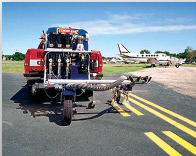
Нанесение простых линий
