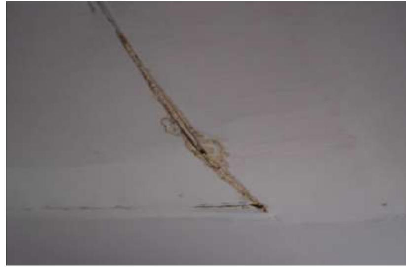
Протекание кровли, вздутие потолка
